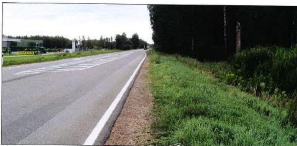
Skats no jaunā pieslēguma DUS virzienā vietas pa autoceļu A7 virzienā uz Bausku.
