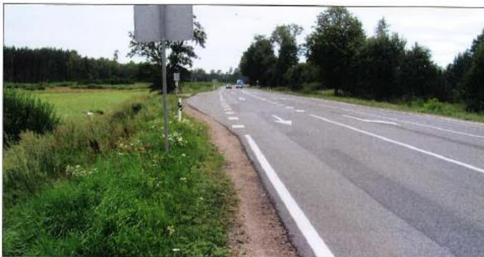
Skats no jaunā pieslēguma DUS virzienā vietas pa autoceļu A7 virzienā uz Rīgu.
